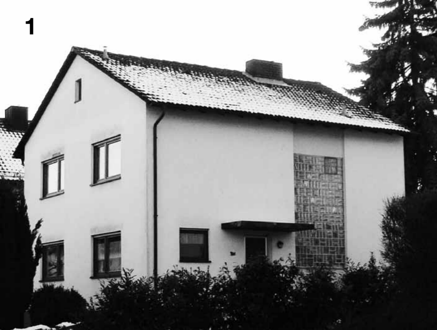
1 Bestand / Ansicht Straßenseite
