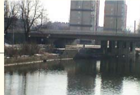
ansicht brücke / dolne miasto
