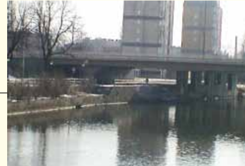
Ansicht Brücke / Dolne Miasto
